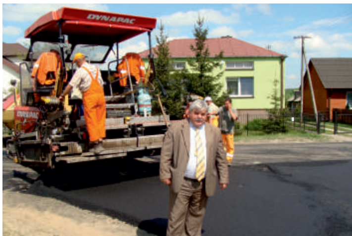
Budowa asfaltowej nawierzchni drogi w Czornówce.
