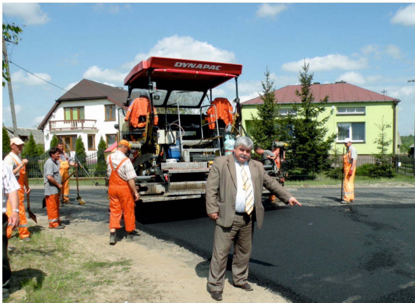
Wójt nadzorował remont nawierzchni drogi w Czosnówce
