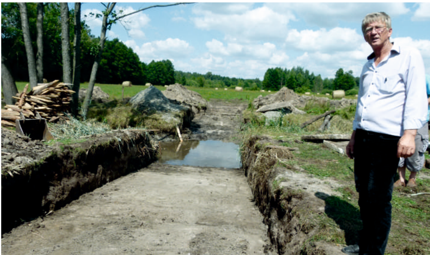
Budowa brodu na Rudce w Janówce
