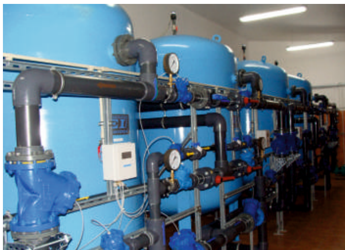
Nowe urządzenia gwarantują bezawaryjną pracę stacji
