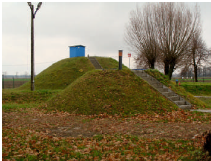
Stacja ujęcia wody w Sworach długo czekała na remont
