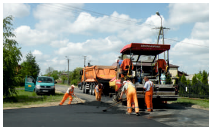
Nakładki bitumiczne pozwoliły usunąć dziury i wyboje
