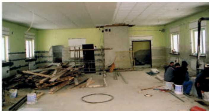
Remont pomieszczeń klubu kultury w Hrudzie
